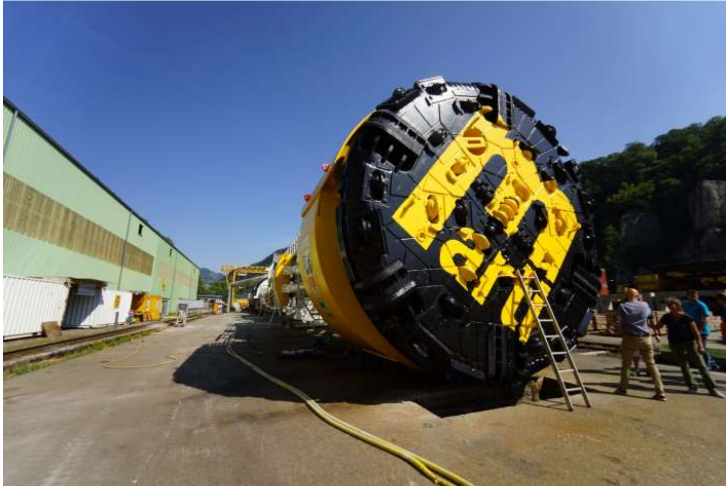
TBM HWS-Sarneraa (Obwalden) (Werhof Marti Klus - Balsthal, (CH))
